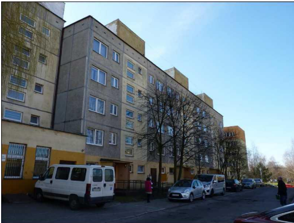
Fotografia 1. Widok od strony wschodniej na część budynku położonego przy ul. Romera 21-29 (segment B)
