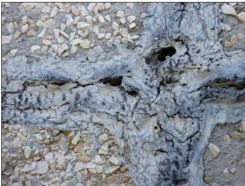
Fotografia 10. Ubytki w elewacji w ścianie zachodniej segmentu C.
