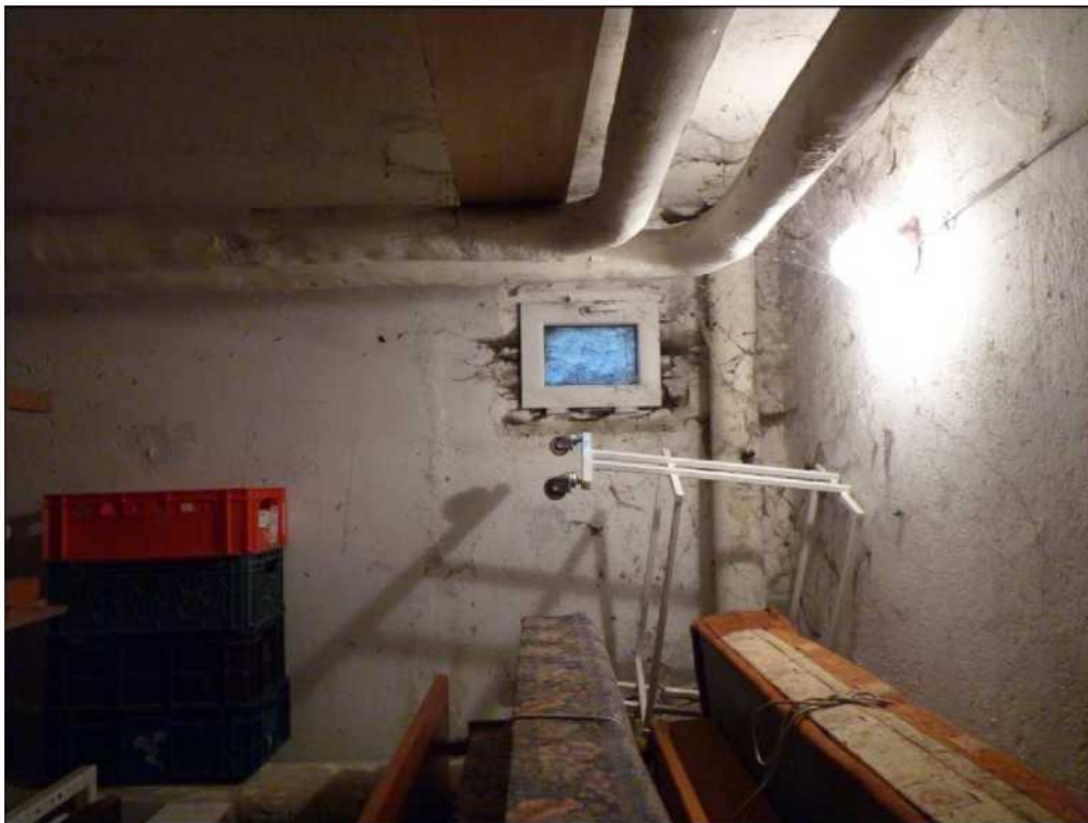
Fotografia 14. Jedno z najbardziej użytkowanych pomieszczeń magazynowych, znajdujących się w piwnicy budynku, w których także nie stwierdzono obecności nietoperzy
