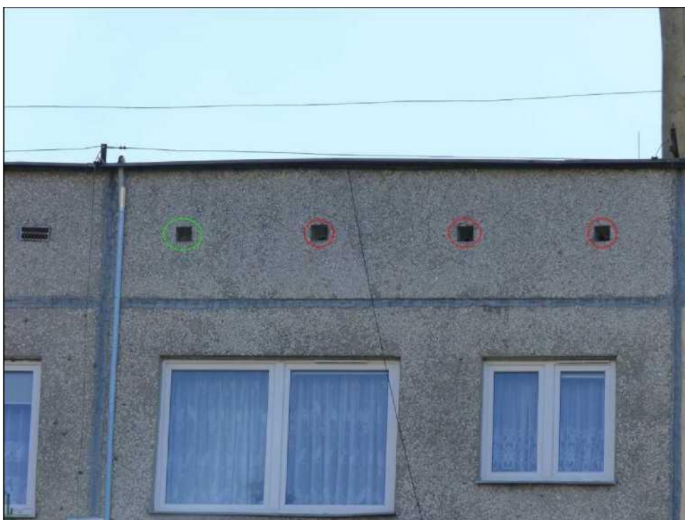
Fotografia 8. Niezabezpieczone otwory wentylacyjne w stropodachu ściany wschodniej segmentu B. Otwory zaznaczono na czerwono posiadają dziury prowadzące w głąb stropodachu, o średnicy ok. 5 cm. Zielony otwór wentylacyjny stanowi wnękę o głębokości 10 cm.
