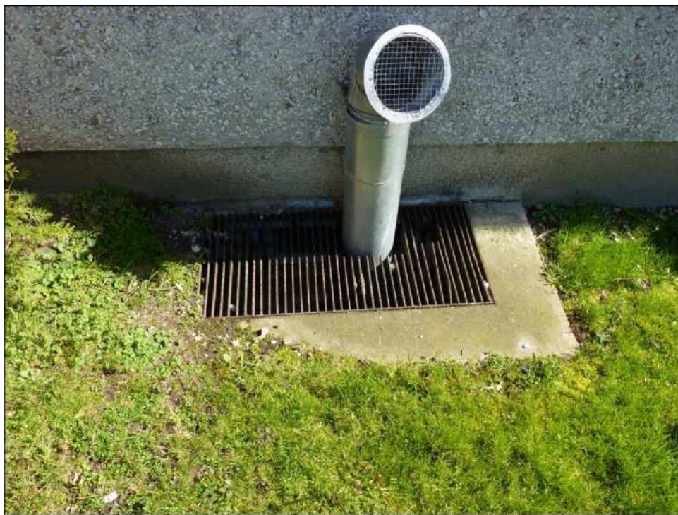
Fotografia 11. Zabezpieczony otwór okienny pomieszczenia w piwnicy budynku
