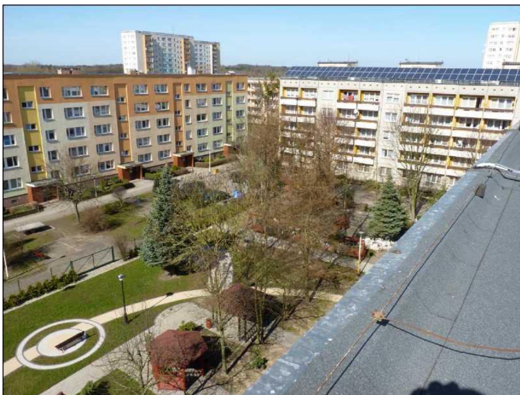
Fotografia 2. Widok z dachu segmentu C, w kierunku północno zachodnim na dziedziniec Domu Pomocy Społecznej oraz część budynku - segment A (na dachu którego zainstalowane są panele fotowoltaiczne)
