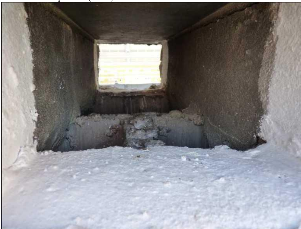
Fotografia 6. Jeden z piętnastu przewodów kominowych zabrudzonych odchodami gołębi Columba livia forma urbana .
