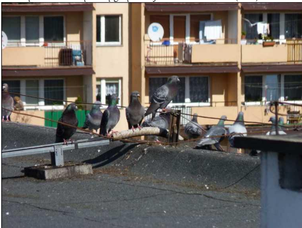
Fotografia 4. Widok z dachu budynku segmentu B na stadko gołębi miejskich
