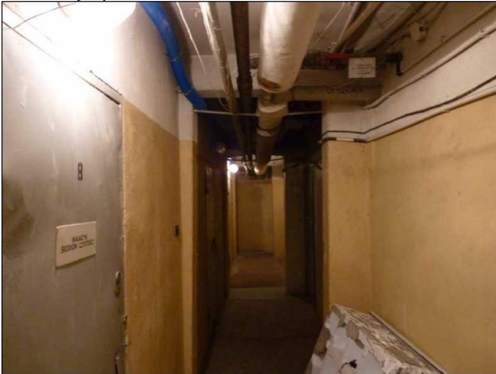
Fotografia 13. Korytarz piwnicy zbadanego budynku. Nie stwierdzono tu kolonii nietoperzy, ani śladów ich występowania.
