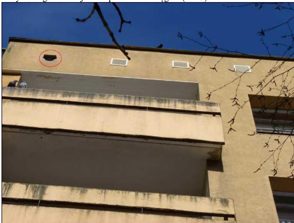
Fotografia 5. W czerwonym kole zaznaczono niezabezpieczony otwór wentylacyjny, w którym gołębie miejskie uwiły sobie gniazdo. Jest to ich miejsce lęgowe.
