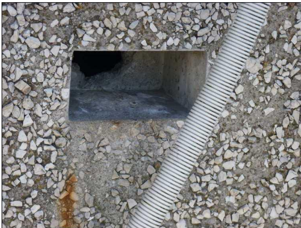
Fotografia 7. Niezabezpieczony otwór wentylacyjny w stropodachu ściany zachodniej segmentu B. W głębi widoczny otwór o średnicy ok. 8-9 cm, a przed nim widoczne odchodami ptasie.
